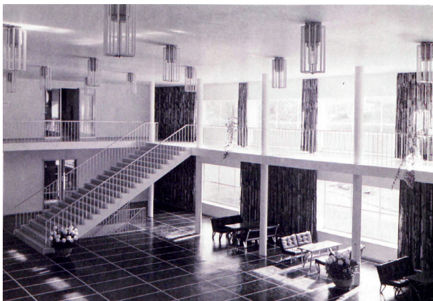
5 Hans Schwippert, Bundeshaus Bonn , 1949, Treppe im Foyer
