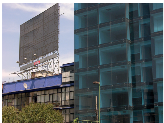
7 Mexiko-Stadt, Ansicht ältere und neuere (blau getönte) Glasfassaden, 2006
