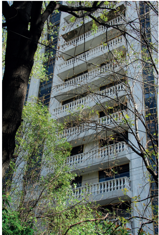
8 Mexiko-Stadt, Wohnhochhaus mit vorgeblendeten Balustraden, 2007
