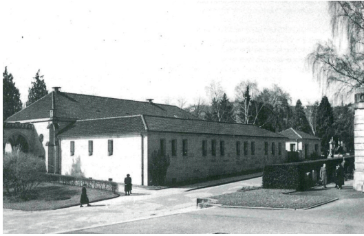
2 Historisches Foto vom Erweiterungsbau des Leichenhauses
