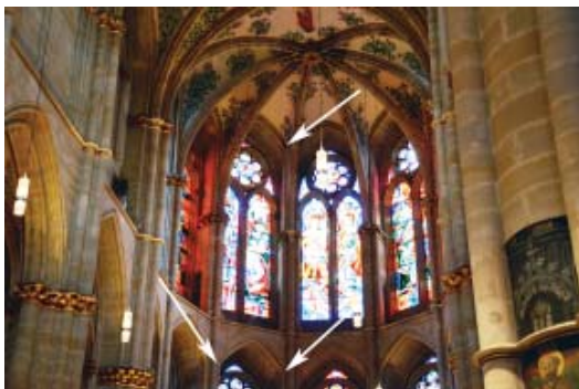
12 Liebfrauen Trier, Obergaden des Chorhauptes mit geraden Fensterlaibungen und gebrochenen Bögen der inneren Fenstereinfassungen (Pfeile)
