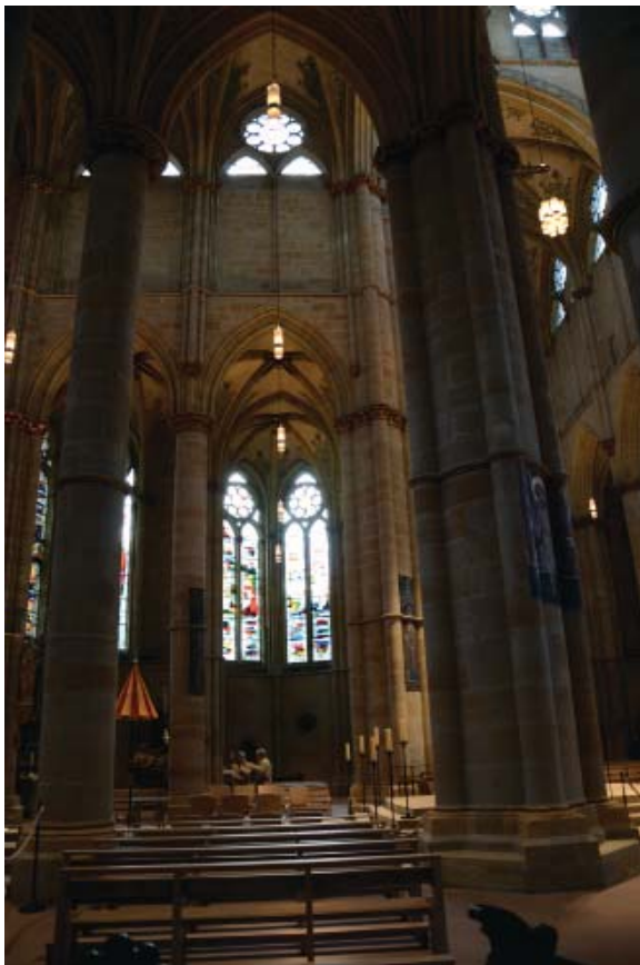
29 Liebfrauen Trier, im Hintergrund flankieren zwei polygonal geschlossene Seitenschiffe und das hoch aufragende Hauptschiff
