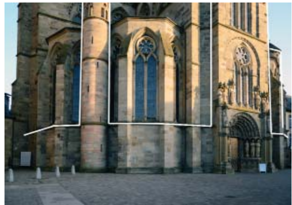
13 Liebfrauen Trier, Umfassungsmauer mit wehrhaftem Sockel und massiven Türmen
