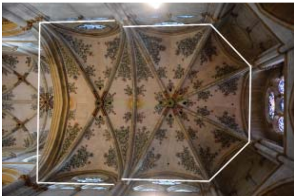
34 Liebfrauen Trier, Blick ins Querhausgewölbe; die Joche wurden als getrennte Gehäuse angelegt
