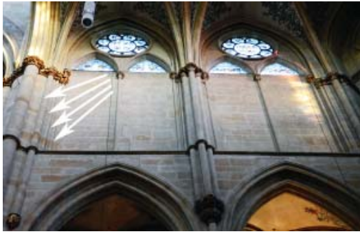
10 Liebfrauen Trier, Innenansicht des Obergadens mit ausgedünnten Wandschichten
