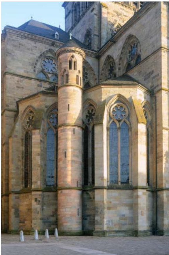
6 Liebfrauen Trier, Blick auf den blockhaft kreuzförmigen Baukörper als Sockel des Turmbaus; davor kontrastreich abgesetzt die Kapellenanbauten samt Treppenturm
