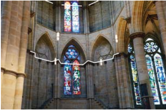
28 Liebfrauen Trier, Südquerhaus mit Arkatur, die durch die Gesimse fest mit der unteren Wandzone verbunden sind; oben zeigen es die Gesimse an, dass sich die Wand als lichter Schirm hinter den Wandpfeilern aufspannt
