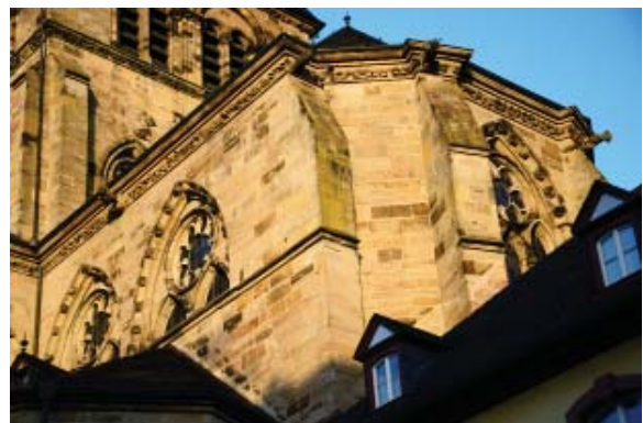
9 Liebfrauen Trier, Außenansicht einer Obergadenwand mit Strebepfeiler an der Stirnseite; die Obergadenfenster sind dicht zum Turm hin gerückt
