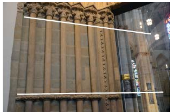
22 Liebfrauen Trier, Portalgewände- und Vierungspfeilersäulchen in ihrer Zusammenschau; die Proportionierung und Stellung der Portalgewändesäulchen scheinen unmittelbar auf die Größe und Disposition der Dienste der Hauptpfeiler abgestimmt
