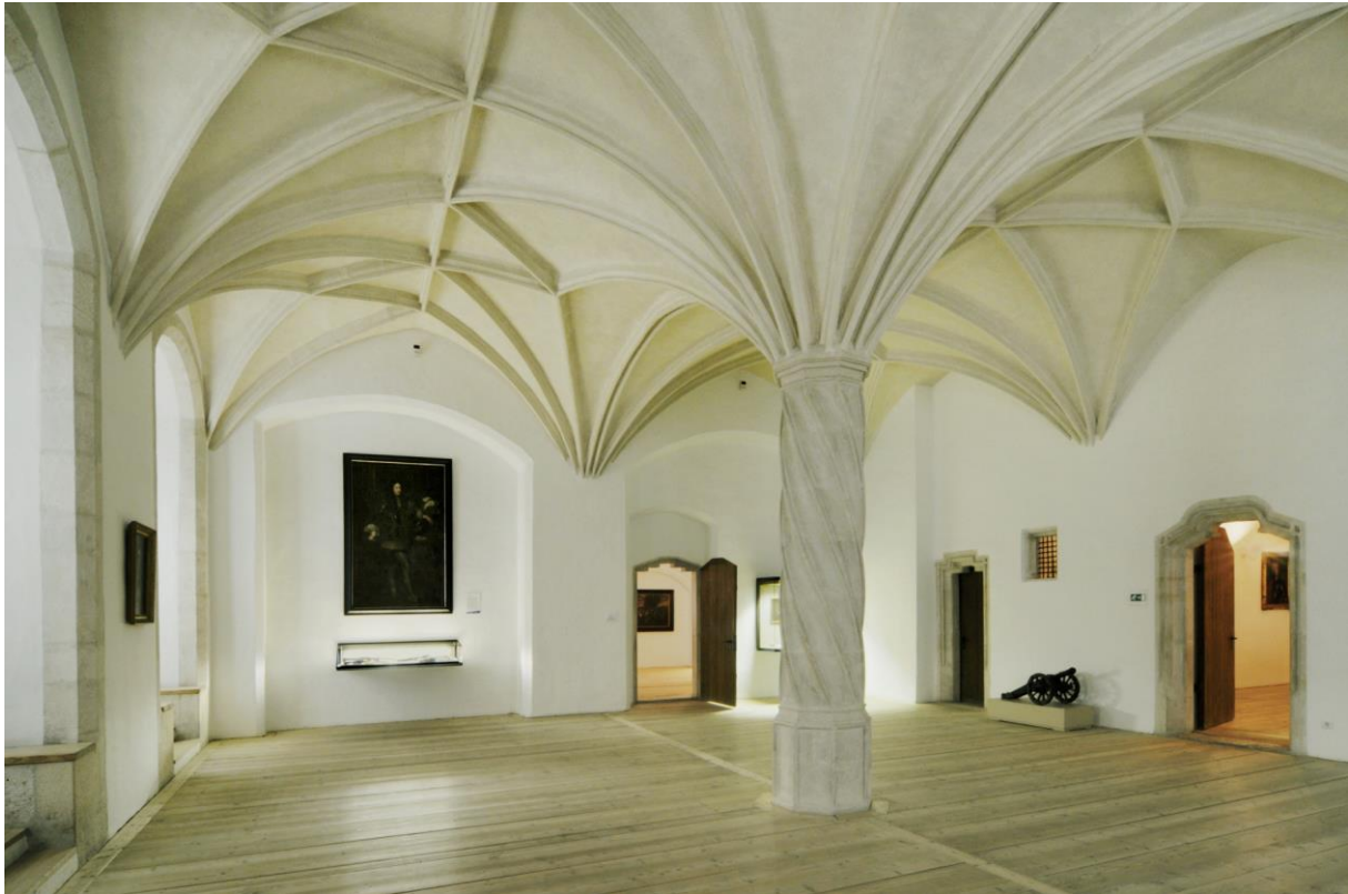
Abbildung 14: Neues Schloss Ingolstadt, Palas, erstes Obergeschoss, Schöner Saal (herzogliche Stube), Ansicht von Südwesten
