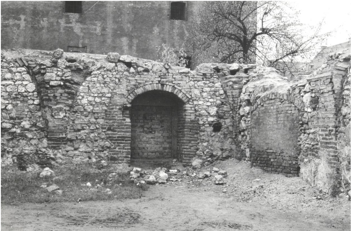
Abbildung 8: Vorgängerbau des Fahnenhauses, Innenraum von Osten, Zustand vor Wiederaufbau in den 1960er Jahren
